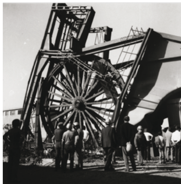
1971, puits central de May-sur-Orne, destruction du chevalement.
