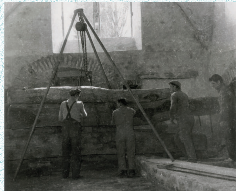
Photographie, « Installation du pressoir à longue étreinte dit prinseux, datant du 17 e siècle ». Collection ville de Valognes.
